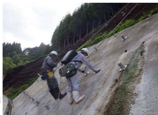
施工後の補強材長測定状況
