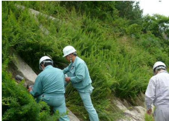
供用中鉄筋挿入工の長さ測定
